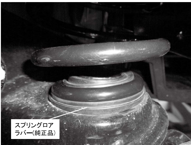
リアスプリングロア側取り付け状態 ※スプリングロアラバーがしっかりとハマっているか 確認してください
